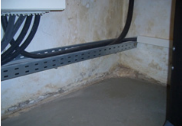
Abb.: Feuchtigkeitsschäden
